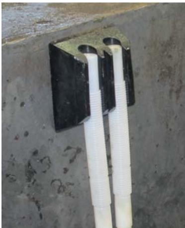
Kuva 8 Päätevaraus tehty kumisella magneetilla, johon on kiinnitetty taipuisat pääteholkit.
