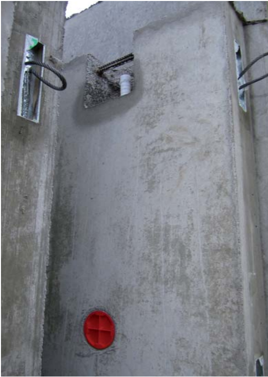
Kuva 33 Kojerasia ja pääteholkki varauksessa.
