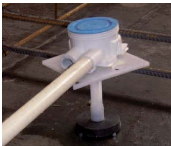
Kuva 4 Kojerasian tuki ja pohja ABB:n sekä Schneider Electricin rasiatyypeille.
