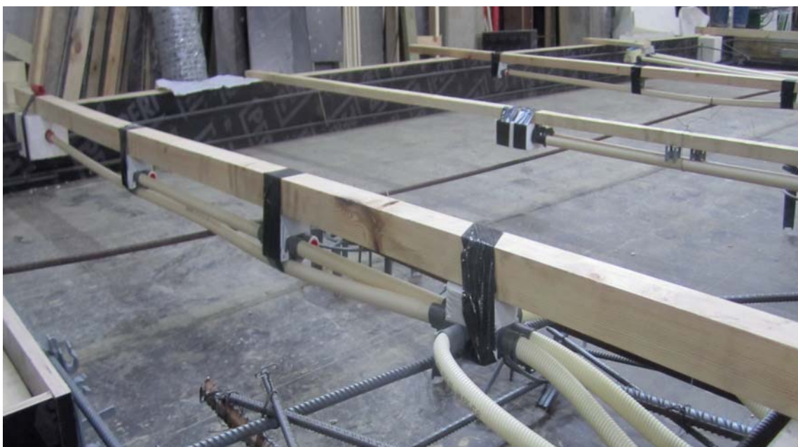
Kuva 20 Kojerasiat ja jakorasia kiinnitetty teipillä tukipuuun.
