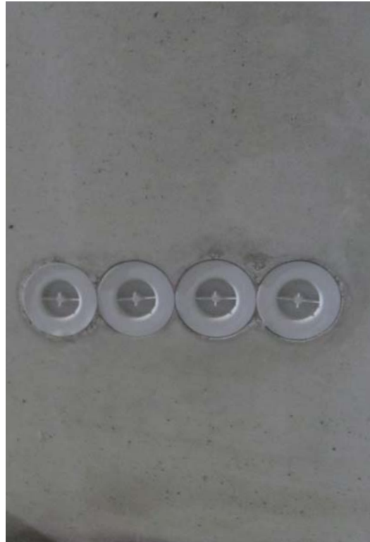
Kuva 34 Neljä kojerasiaa asennettuna.
