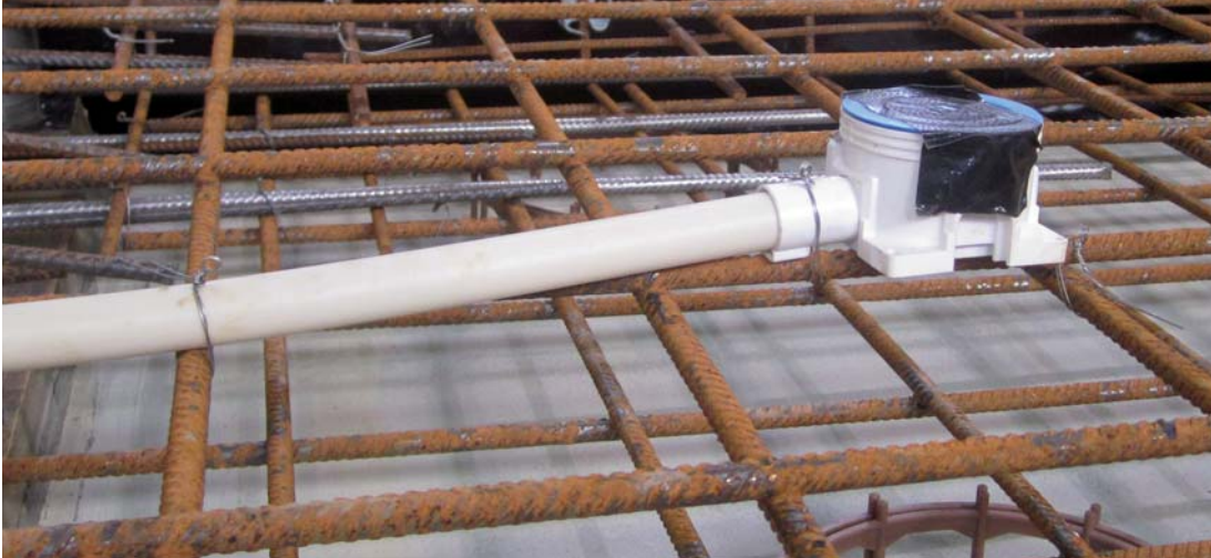
Kuva 26 Etupinnan kojerasia ja sähköputki kiinnitetty teräksiin.
