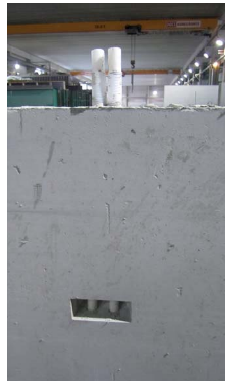
Kuva 32 Kiinnikkeen jälki paika- taan elementin pinnasta. Sähkö- putkissa käytetty taipuisia jatkoja.
