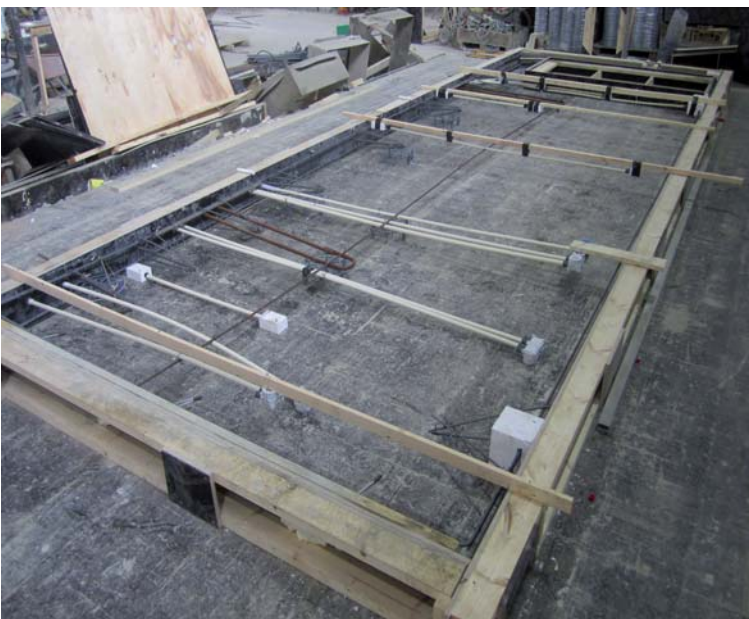
Kuva 15 Mallielementin V-02 sähköasennukset.
