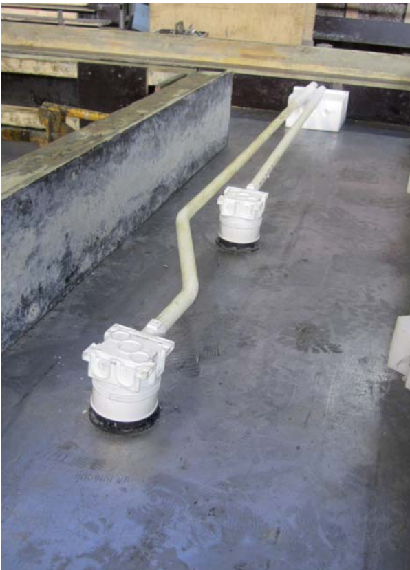
Kuva 27 Korotetut kojerasiat kiinnitetty magneetilla.
