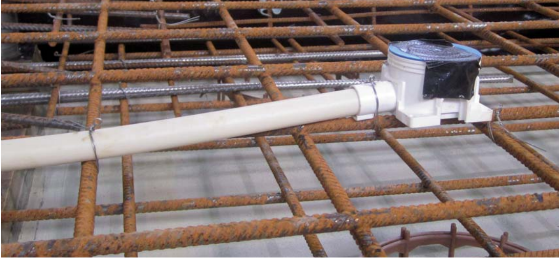
Kuva 26 Etupinnan kojerasia ja sähköputki kiinnitetty teräksiin.
