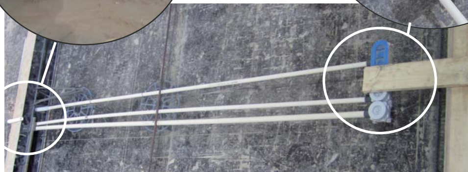
Kuva 17 Mallielementin asennetut kaksoiskojerasiat.
