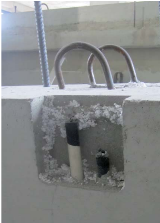
Kuva 35 Polystyreenillä tehty varaus ennen puhdistusta. Sähköputki suojattu teippaamalla. Polystyreenivarauksen voi päällystää liimapintaisella muovikalvolla, jolloin varauksen irroitus ja puhdistaminen on helpompaa.
