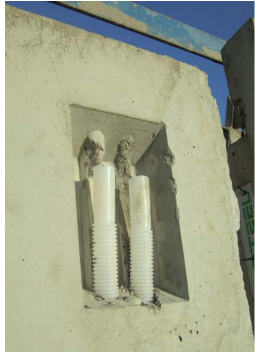
Kuva 30 Kuvan 29 varaus valmiissa elementissä. Taipuisat pääteholkit tart- tuvat betoniin, joten ne pitää irroittaa kuvan mukaisesti betonista.
